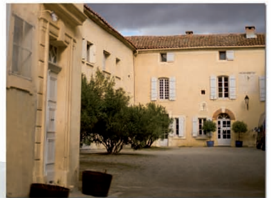
Puech Cocut : Cave du Château de Raissac
